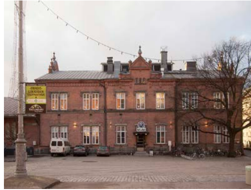
Tullikamarin julkisivu itään Tullikamarin aukion puolelle.
