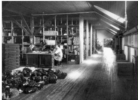
Attilan kenkätehtaan tarvikevarasto sijaitsi tehtaan ullakkokerroksessa 1910-luvulla. Hyllyjen edustalla erottuu nykypäiväänkin säilyneet kattoa kannattavat monihaaraiset pilarit. (Niels Rasmussen, Tampereen museot)
