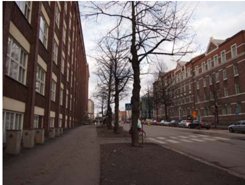
1954 vuonna rakentuneen osan julkisivua Yliopistonkadulle.
