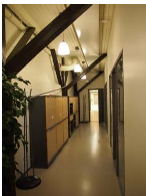
Ullakkokerroksen kattoa kantavat puurakenteet sekä kattoikkunat toimistotiloissa ja käytävässä.
