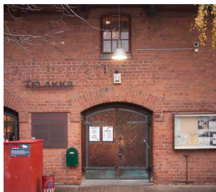
Telakan pääsisäänkäynti Tullikamarin aukion puolelta. Yläpuolella vanha valaisin.
