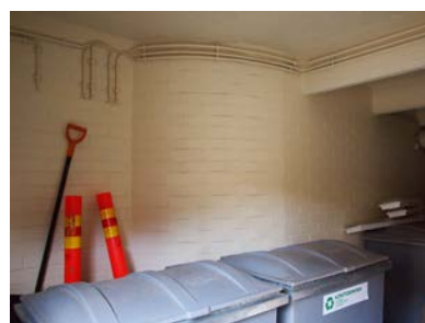
Entisen tallirakennuksen sisäpuolella näkyy vanha rakenteita, kuten tiiliseinää ja palkkeja. Katossa on jälkiä betonin valussa käytetystä muostista.
