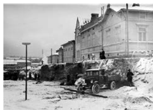
Itsenäisyydenkadun madaltamista rautatien allittavan tunnelin rakentamisen yhteydessä. (Kuva: Tampereen museot)
