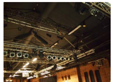
Pakkahuoneen säilynyt kattorakenne jää nykytilanteessa piiloon teknisten rakennelmisen taakse.
