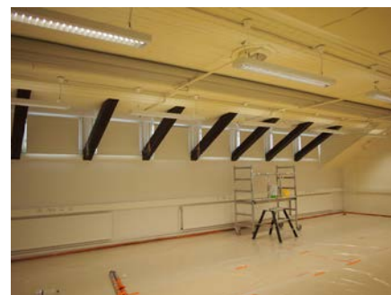
Kattorakenne näkyvillä ullakkokerroksessa.
