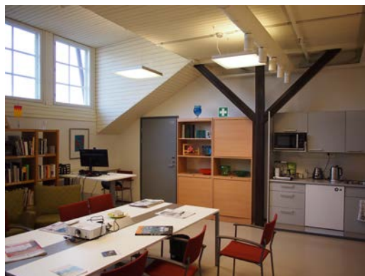
Ullakkokerroksen kattoa kantavat puurakenteet sekä kattoikkunat toimistotiloissa ja käytävässä.
