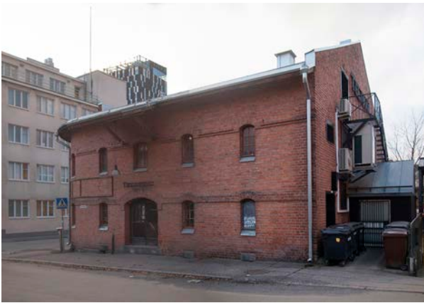
Telakka Pinninkadulle, pohjoisvillulla paloportaat sekä pieni huoltosiipi ja jätehuolto.
