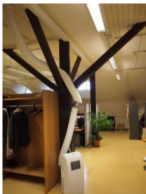
Ullakkokerroksen kattoa kantavat puurakenteet sekä kattoikkunat toimistotiloissa ja käytävässä.
