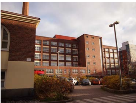
Vuonna 1954 rakentuneen osan julkisivua sisäpihan puolelta.
